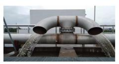
浙江山鹰厂区进行"雨污分离"技改,实现了雨水资源化利用,不仅减轻了污水处理系统的负担还降低了取水成本。
